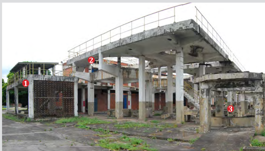
Figura 18 — Usinas de craqueamento de gás de nafta inauguradas em 29 de maio de 1970 no terreno da antiga “Fábrica Nova de Gás”, situada entre a avenida do Mangue e as ruas Pedro Ivo e Souza e Melo. Capacidade de produção: 600.000 metros cúbicos de gás diários. À direita da fotografia, vê-se um dos antigos gasômetros. V. fig. 17.
