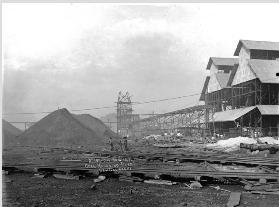
FIG.3: Fábrica de manuseio do carvão, Gasômetro, 1911. À direita, retortas de destilação, unidas por um caminho suspenso para descarga do carvão. O caminho continuava por uma ponte, que conectava o Canal do Mangue à fábrica. A ponte foi demolida na década de 1970, para a construção do Elevado do Gasômetro.
