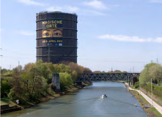
GASÔMETRO DE OBERHAUSEN, ALEMANHA
